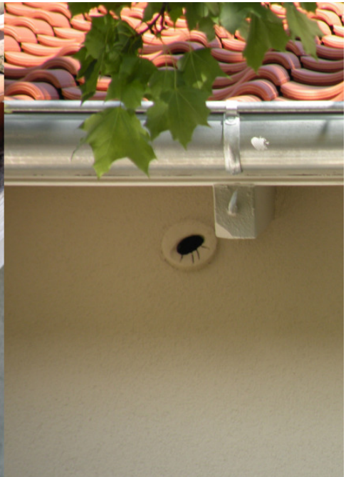
Mauerseglernest unter den Dachziegeln vor der Sanierung und in die Wärmedämmung integrierter Niststein nach der Gebäudesanierung.
