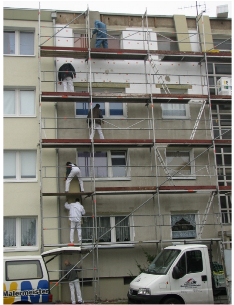
Für die Sanierung wird die Attika abgenommen
